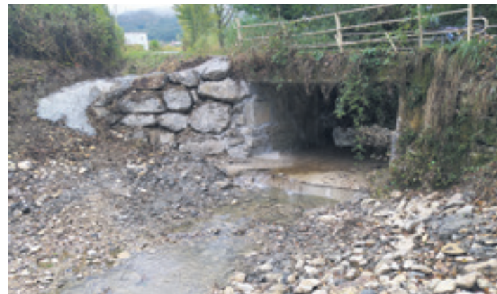
Ezkerretako harrizko estribua konpondu eta zubi azpian porlana jarri dute.
