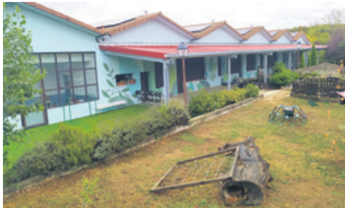
Kattuka haur eskola, estalpea eta berdegunea.
