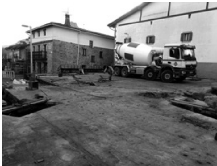
Langileak estalpearen oinarriak eta zorua prestatzeko lanak egiten. UTZITAKOA
