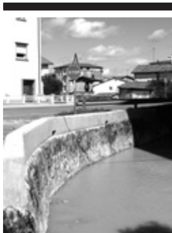
23 bat metro luze eta 0,5 altu da.
