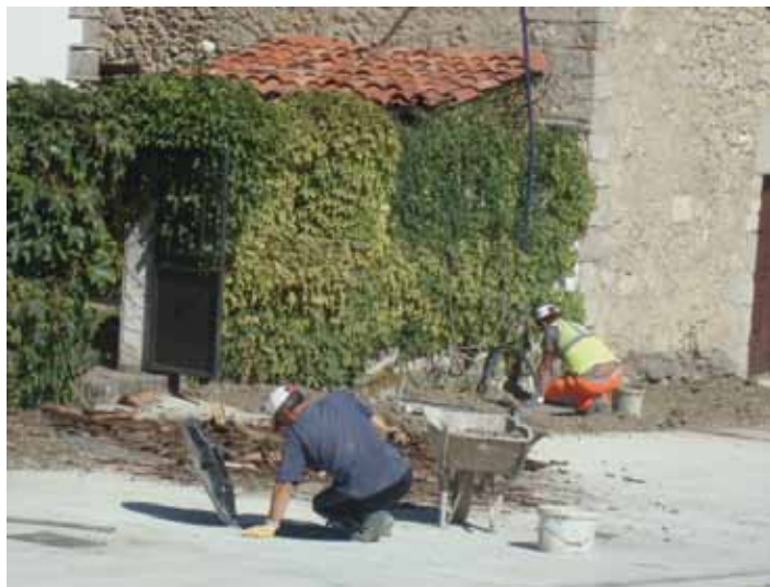
Langileak Santrustegiko sare eta zolatzeko lanak despiditzen.
